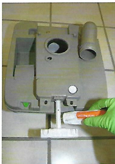
*Après avoir remplacé le joint, il n'y a plus qu'à graisser toutes les pièces en mouvement avec un peu de vaseline pour faciliter le fonctionnement. Sur le W-C portable, cela se résume à enduire la tige de la tirette.*
