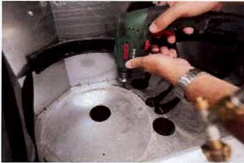
Percez les orifices à l'aide d'une perceuse dotée d'une mèche de 10 mm.
