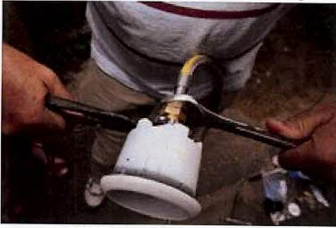
← Avant de mettre en place la coupelle, enduisez le col avec une colle-mastic de type Sika 221 afin d'éviter les risques d'infiltration d'eau. →
