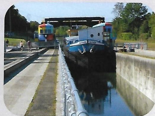
Insolite la Pente d'eau de Montech, unique au monde : mise en service en 1974, nombre d'écluses évitées 5, temps gagné 45 mn, longueur de la pente 486 m, dénivelé 13,30 m, poids 1700 tonnes, poussée d'eau 1500 m<sup>3</sup> sur 125 m, fermeture à la navigation en 2009
